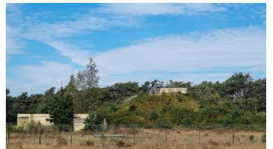
Kerosineheuvel. 2 miljoen liter opslag, loopt door diep in de grond. Hier liep vroeger ook een NAVO-kerosineleiding
