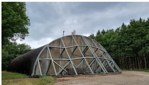
Vliegtuigshelter. Hier kon één straalvliegtuig in staan met toebehoren. Door bolvorming bestand tegen drukgolf zware explosies, behalve voltreffers.
